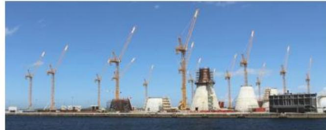
Fabrication des fondations gravitaires en béton de Bouygues TP sur le port du havre pour le projet de Fécamp
