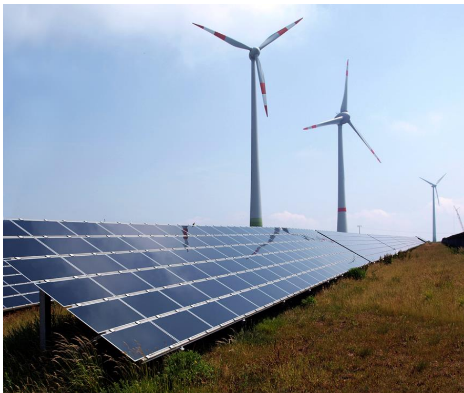
Figure 4-5: parc éolien en co-implantation de Schneebergerhof, Allemagne 69
